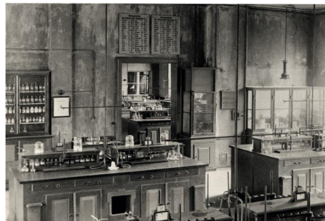
Winklers saniertes Laboratorium in Freiberg
