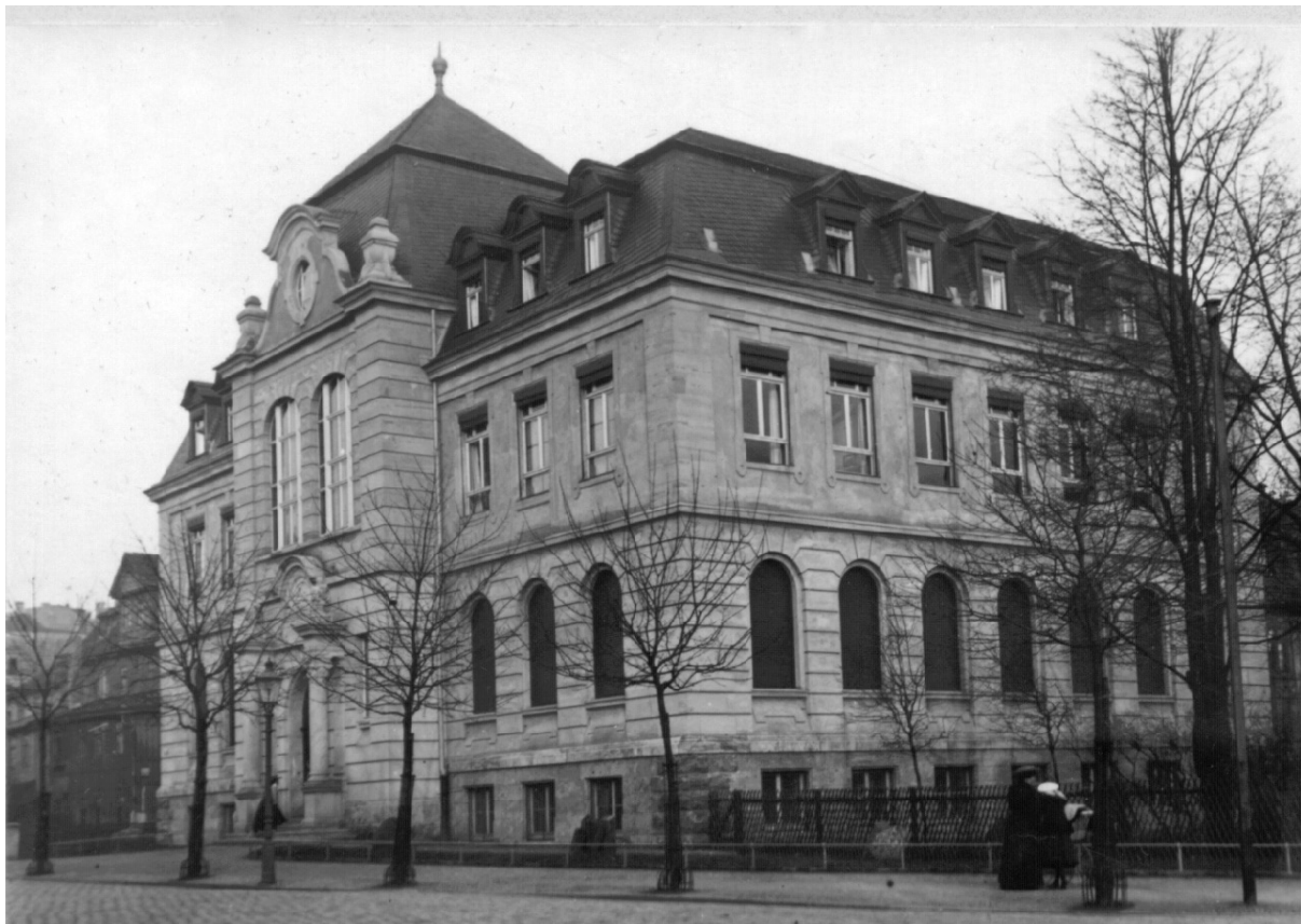
Abb. 1 Ansicht des Institutsneubaus für Mineralogie und Geologie 1905 in der Schillerstraße in Jena (Heide et al. 2000)
