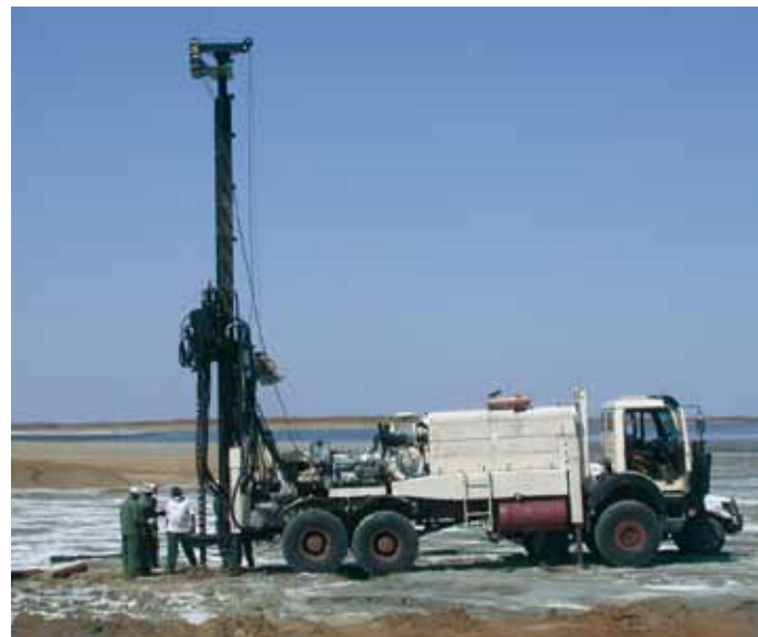
Bohrung auf der Halde mit Aufbereitungsrückständen der Cu-, Ni- und Co-Mine in Selebi-Phikwe, Botswana.
